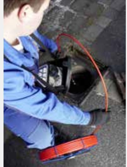
Avec le dévidoir pour caméra, vous disposez également d'un équipement professionnel pour l'inspection de tuyaux de canalisation.
