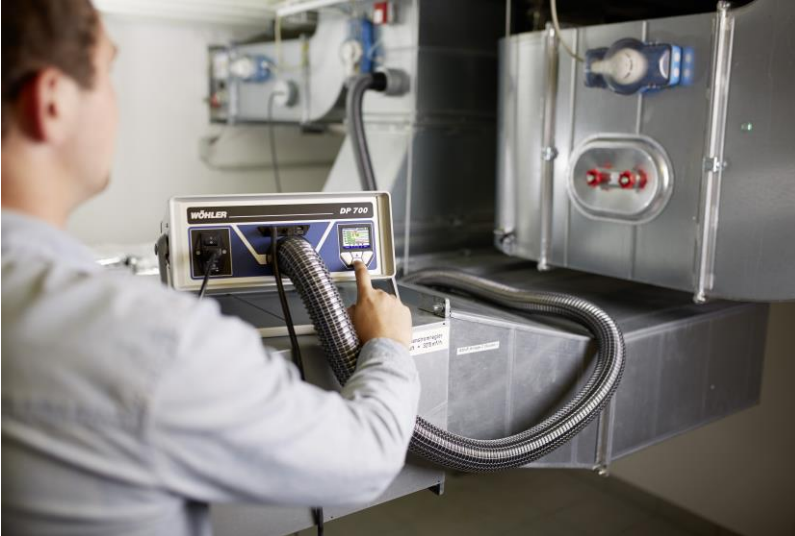
Abb. 11: Beispiel Messaufbau Überdruckmessung ohne Adapter
