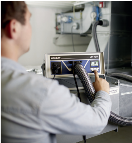
Dichtheitsprüfung an installierten Luftleitungssystemen mit mehreren 100 m 2 .
