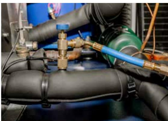
Flexibles de charge et de tirage au vide avec vannes de service
